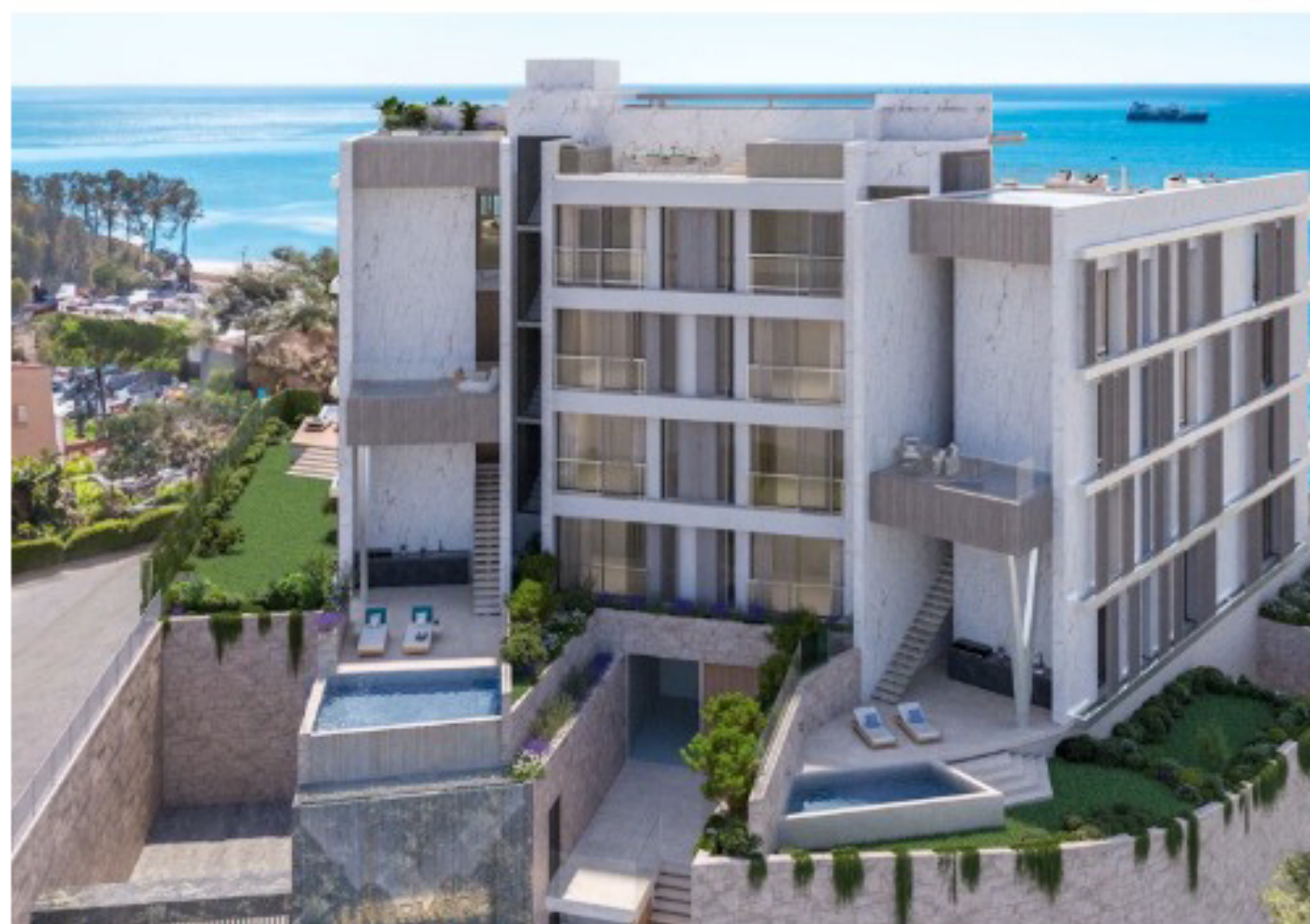
Fachada del futuro edificio hacia el camino de la Desviación. Sur
